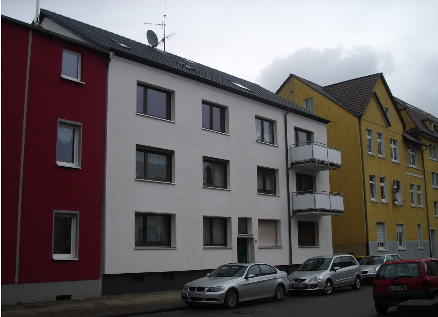
6-FH in Gelsenkirchen, wärmetechnisch 2010 saniert, Endenergieeinsparung 60%
